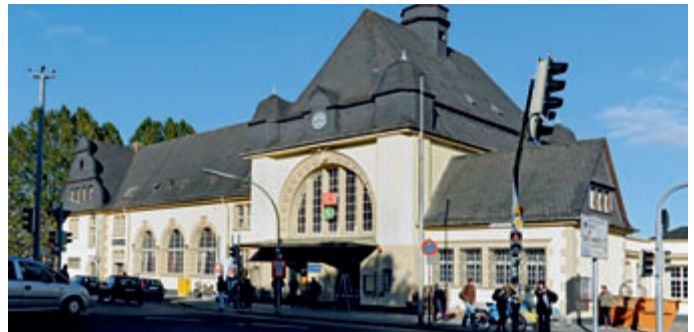
Energetisch saniertes Empfangsgebäude Bahnhof Friedberg (Hessen)
